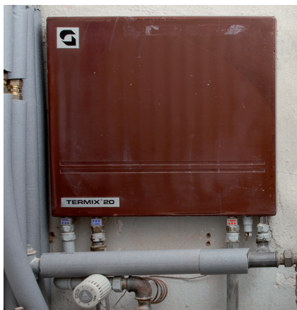
Termix 20 før udskiftning til Termix Novi
