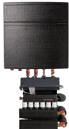
Type A-GE monteret på Termix VMTD opbl. ISO
